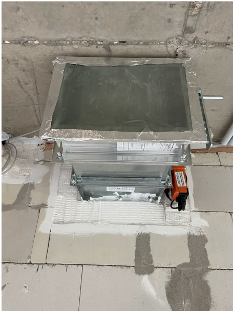
Légcsatornák lezárásának ellenőrzése, a sérült fólia-lezárások javítása
