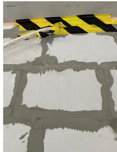
A szerkezetkész 2. ütem felőli kábelátvezető nyílás lezárása
