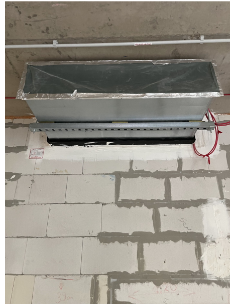
Légcsatornák lezárásának ellenőrzése, a sérült fólia-lezárások javítása
