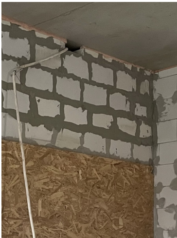
A szerkezetkész 2. ütem felőli kábelátvezető nyílás lezárása
