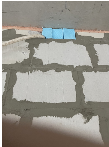
A szerkezetkész 2. ütem felőli kábelátvezető nyílás lezárása
